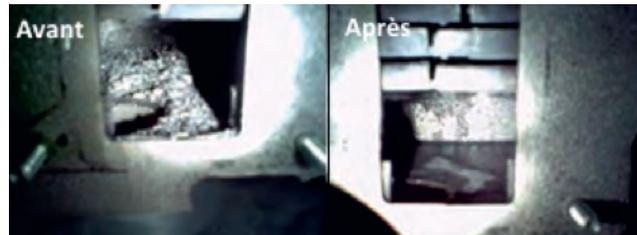
Dépôt dans le fond de l'échangeur
